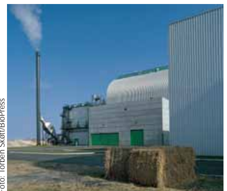
Foto: Torben Skott/BioPress Halmfyret kraftvarmeværk i Masnedø.
