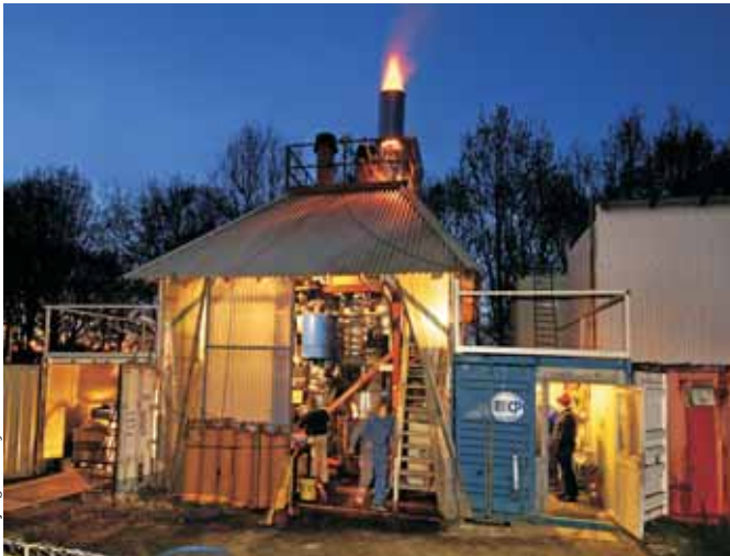
Forsøg med 500 kW LT-CFB-forgasser på DTU.
