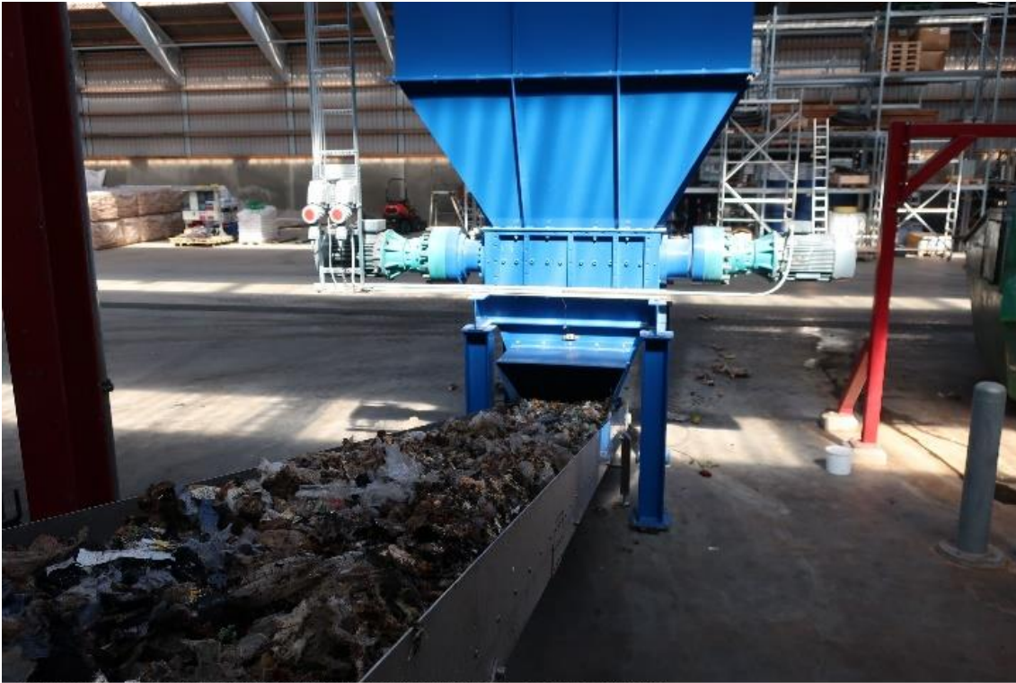
De Waster selskabs separation - selskab efter neddel og for separationsanl, 19.04.2010, kl. 12:11
