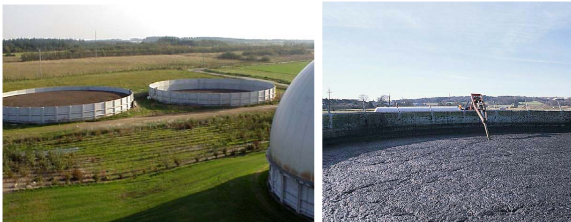
Figura 7.31. Tancuri de stocare acoperite cu straturi naturale de flotație (AL SEADI, 2008)
