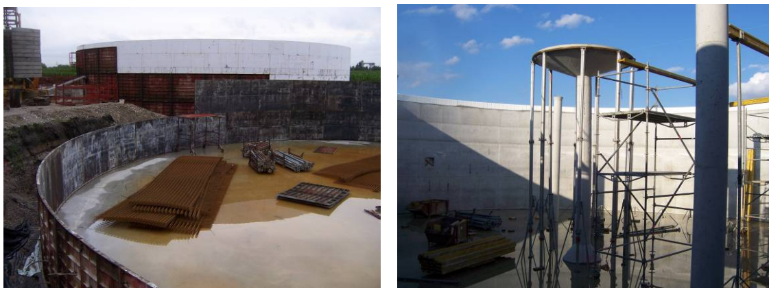
Figura 7.20. Construcția la fața locului a digestoarelor verticale din beton armat (RUTZ, 2007)
