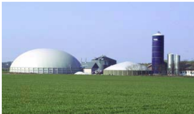
Figura 4.5. Imagine a unei fabrici de biogaz de nivel fermier din Danemarca, de co-digestie a gunoiului animal și a materialului provenit din culturi energetice (GROENGAS A/S)
