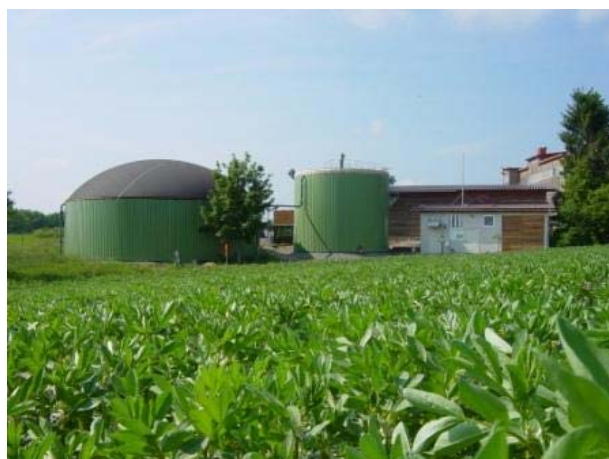
Figura 4.6. Digester vertical din Germania, pentru procesarea dejecțiilor provenite din fermele de porci și păsări și a biomasei vegetale însilozate (KRIEG AND FISHER, 2008)
