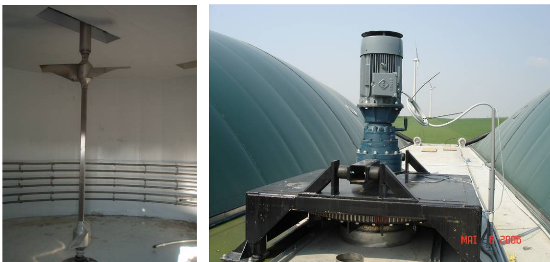
Figura 7.22. Mixer de plafon cu palete (stânga) și motorul acestuia (dreapta) (AGRINZ GmbH, 2006)
