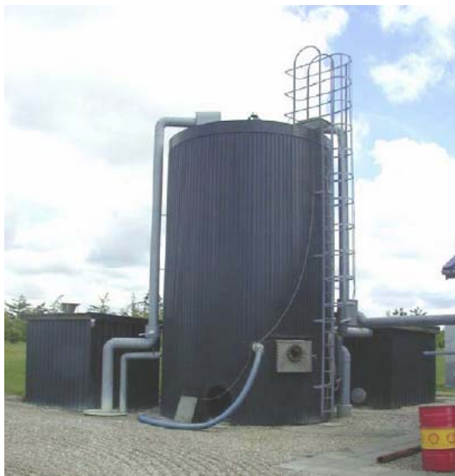
Figura 7.30. Tanc de reacție pentru îndepărtarea hidrogenului sulfurat (ANGELIDAKI, 2005)
