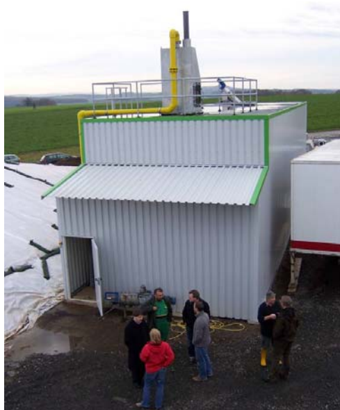
Figura 7.21. Digestoare orizontale cu flux lent “EUCO®”, ale Schmack Biogas, cu un volum de 400 m 3 (RUTZ, 2006)
