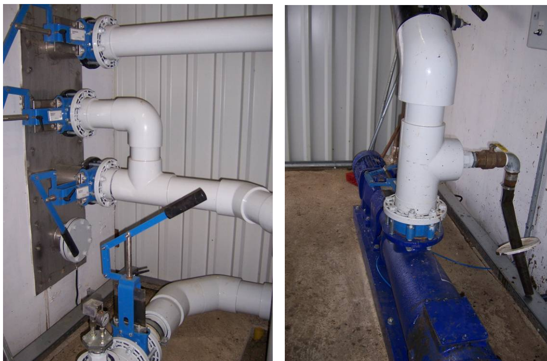
Figura 7.8. Valve de închidere (stânga) și sistemul de pompare (dreapta) (RUTZ, 2006)
