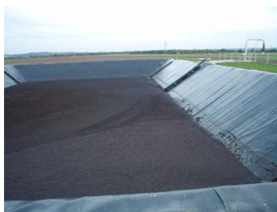
Figura 7.34. Stocarea digestatului în bazine construite în aer liber (AGRINZ GmbH, 2006)
