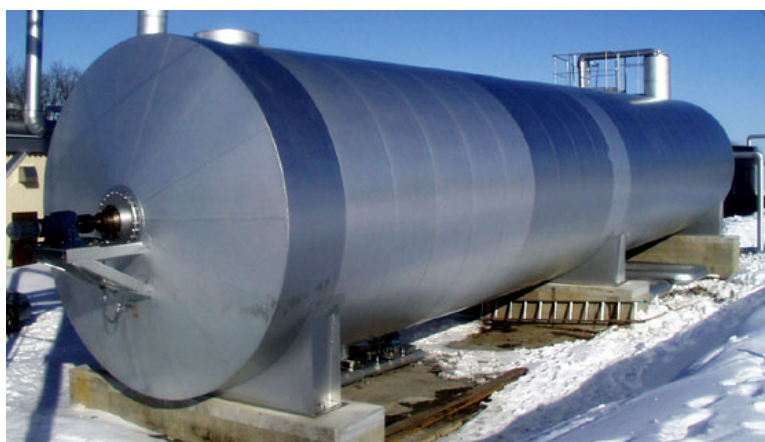
Figura 4.3. Digestor orizontal, construit în Danemarca (Nordisk Folkecenter, 2001)
