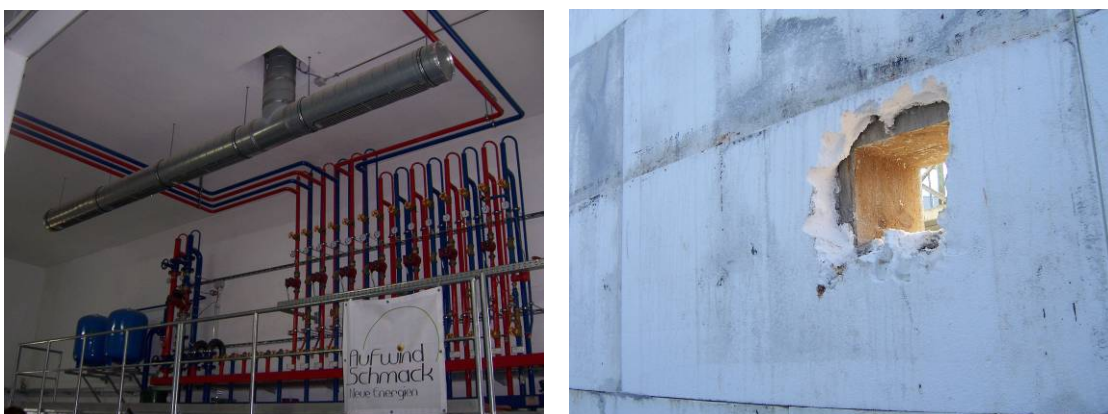
Figura 7.16. Sistemul de încălzire al unei fabrici de biogaz (stânga) și izolarea unui digester din beton armat, aflat în construcție (dreapta) (RUTZ, 2008)
