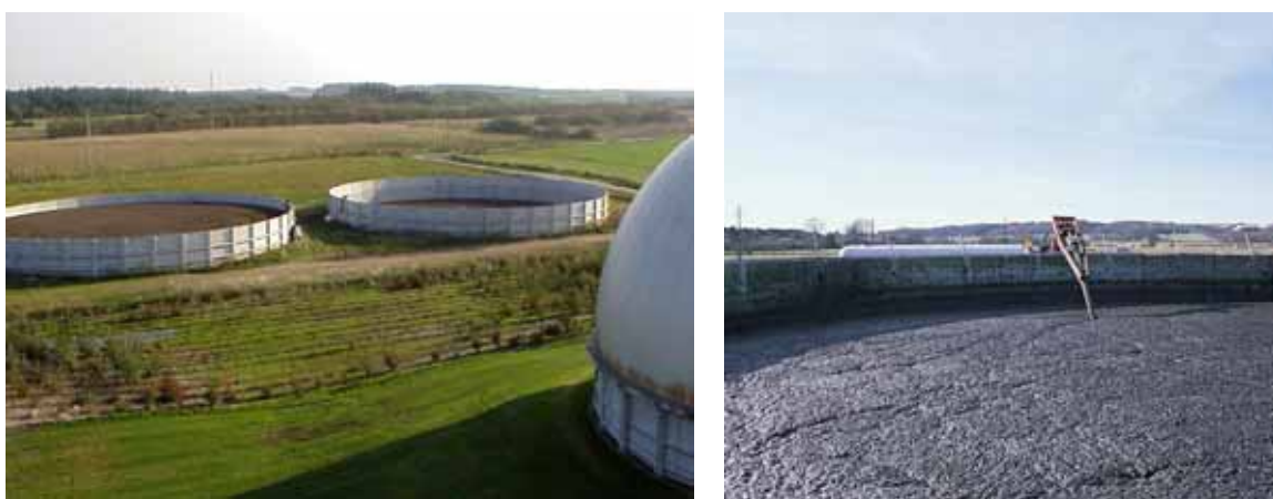
Slika 7.32. Spremišta za skladištenje digestata pokrivena prirodnim plutajućim slojem
