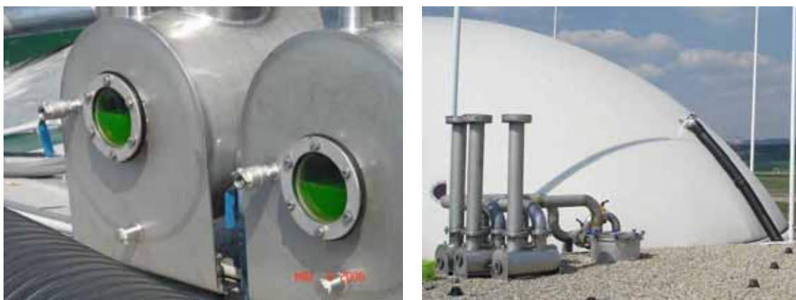
Slika 7.25. Sigurnosni tlačni objekti i ventili
