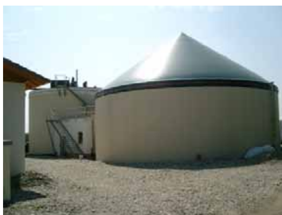
Slika 4.7. Vertikalni digestor u Njemačkoj izgrađen 2005. godine za fermentaciju energetskih usjeva
