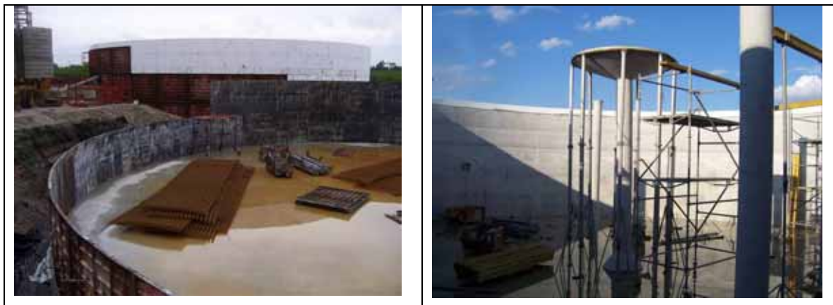
Slika 7.20. Izgradnja vertikalnih fermentatora od betona
