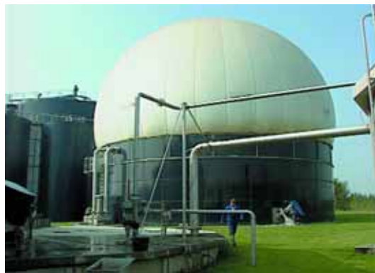
Slika 7.33 Spremišta za skladištenje pokrivena membranom
