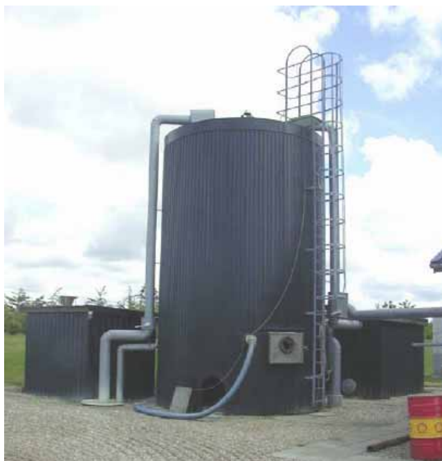
Slika 7.31. Reakcijsko spremište za odvajanje sumporovodika
