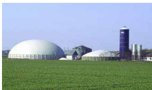
Slika 4.5. Postrojenje za proizvodnju bioplina na farmi u Danskoj, kodigestija stajskog gnoja i energetskih usjeva
