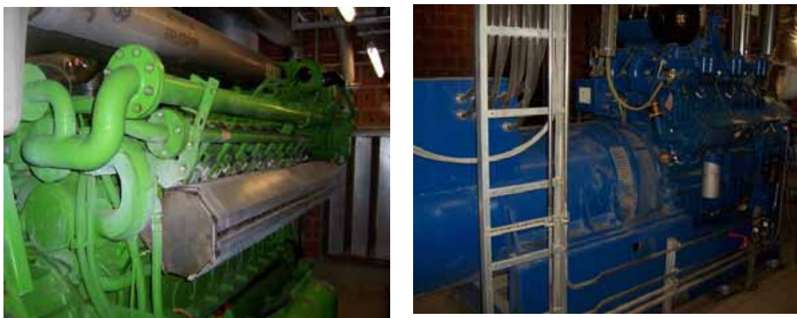
Slika 5.3. Plinski-Otto motor
