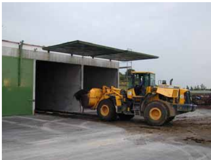
Slika 7.18. Garažni obročni fermentator koji se puni traktorom
