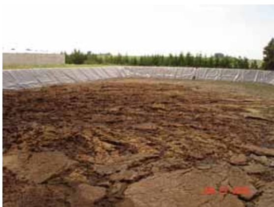
Slika 7.34 Otvorene laguna za skladištenje digestata
