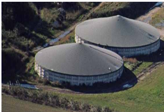
Slika 7.33 Spremišta za skladištenje pokrivena membranom
