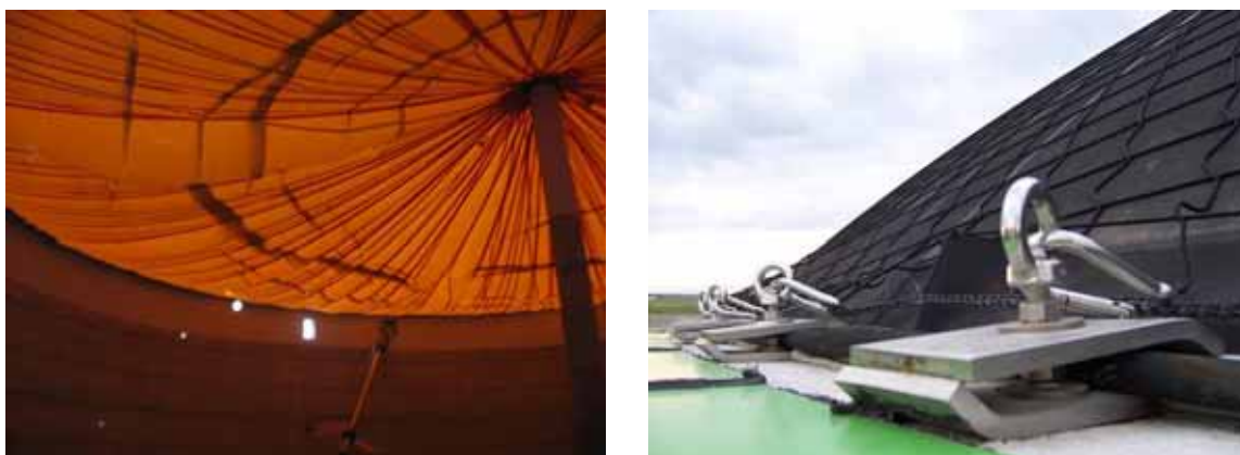
Slika 7.27. Plinsko nepropusna membrana kao pokrivač fermentatora, pogled s unutarne strane fermentatora (lijevo) i pogled s vanjske strane gdje se vidi mreža za ograničavanje širenja membrane (desno)
