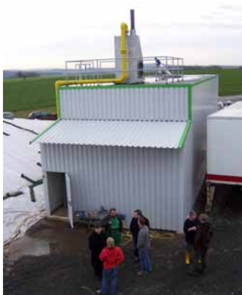
Slika 7.21. Horizontalni fermentator s čepolikim gibanjem supstrata
