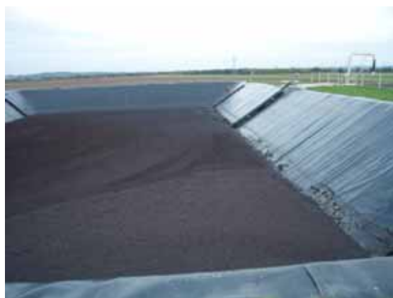
Slika 7.34 Otvorene laguna za skladištenje digestata
