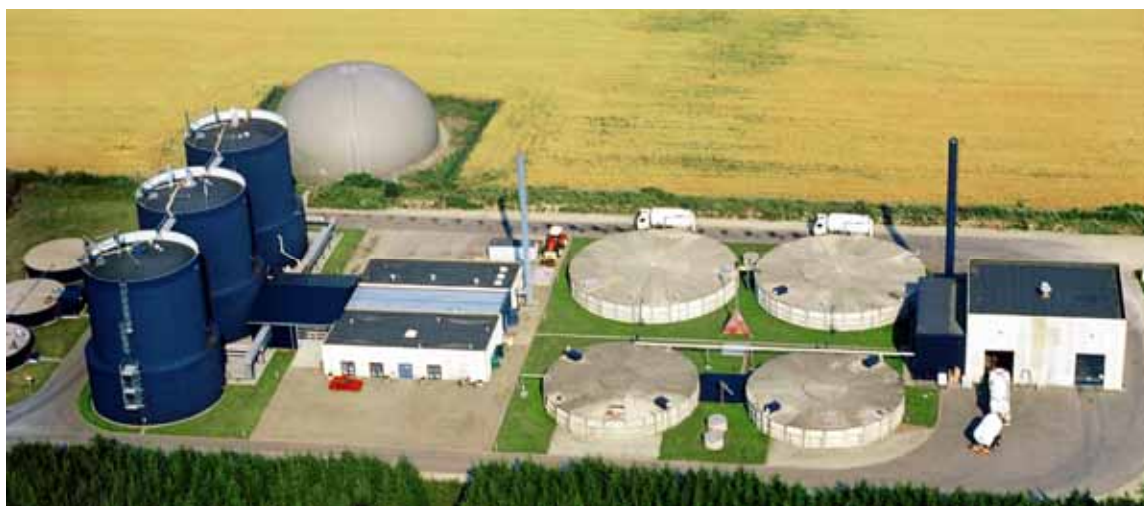
Slika 4.8. Centralizirano postrojenje za ko-digestiju u Danskoj
