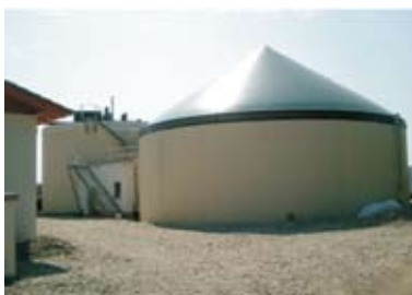
Slika 4.7. Vertikalni digestor za energetske pridelke v Nemčiji, zgrajen leta 2005. Vir: Krieg and Fisher, 2008
