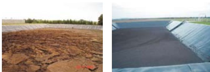
Slika 7.34. Odprte lagune za skladiščenje presnovljenega materiala. Vir: Agrinz, 2006
