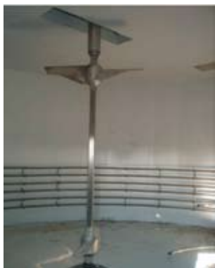
Slika 7.23. Viseči lopatični mešalnik (levo) in njegov motor (desno). Vir: AGRINZ, 2006
