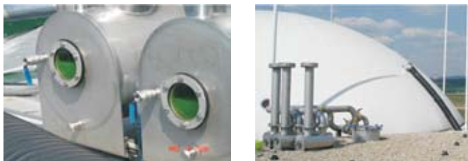
Slika 7.25. Tlačni varnostni pripomočki in ventili. Vir: AGRINZ, 2006
