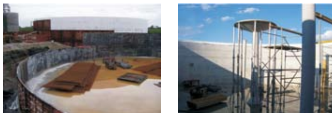
Slika 7.19. Izgradnja vertikalnih digestorjev. Vir: RUTZ 2007
