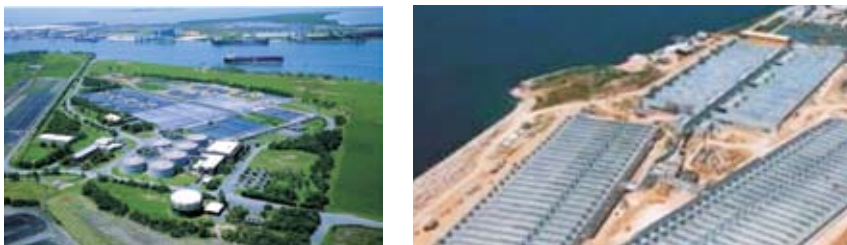
Slika 4.11. Naprava za ravnanje z odpadno vodo skupaj z anaerobno presnovo kot njenim integriranim delom. Vir: http://ian.umces.edu/ 2007.
