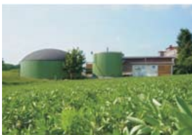
Slika 4.6. Vertikalni digestor v Nemčiji, ki obdeluje prašičji in perutninski gnoj ter silažo. Vir: Krieg and Fisher, 2008.
