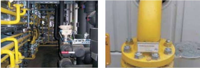
Slika 5.6. Izboljšava bioplina v biometan po metodi PSA (levo) in povezava s plinovodom z zemeljskim plinom (desno) v biometanski napravi v Plieningu, v Nemčiji. Vir: D. Rutz, 2007
