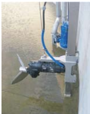
Slika 7.22. Potopni mešalnik s propelerjem, ki ga poganja elektromotor. Vir: AGRINZ, 2006
