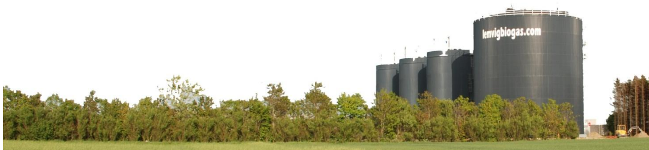
Billede af fire reaktortanke ved Lemvig Biogasanlæg på i alt 14.100 m 3
